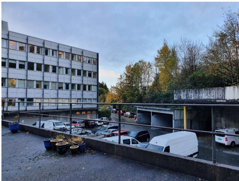
Bilde 2 – Dagens fasade nord, samt parkeringsareal (foto. JMN – plan & arkitektur as)
